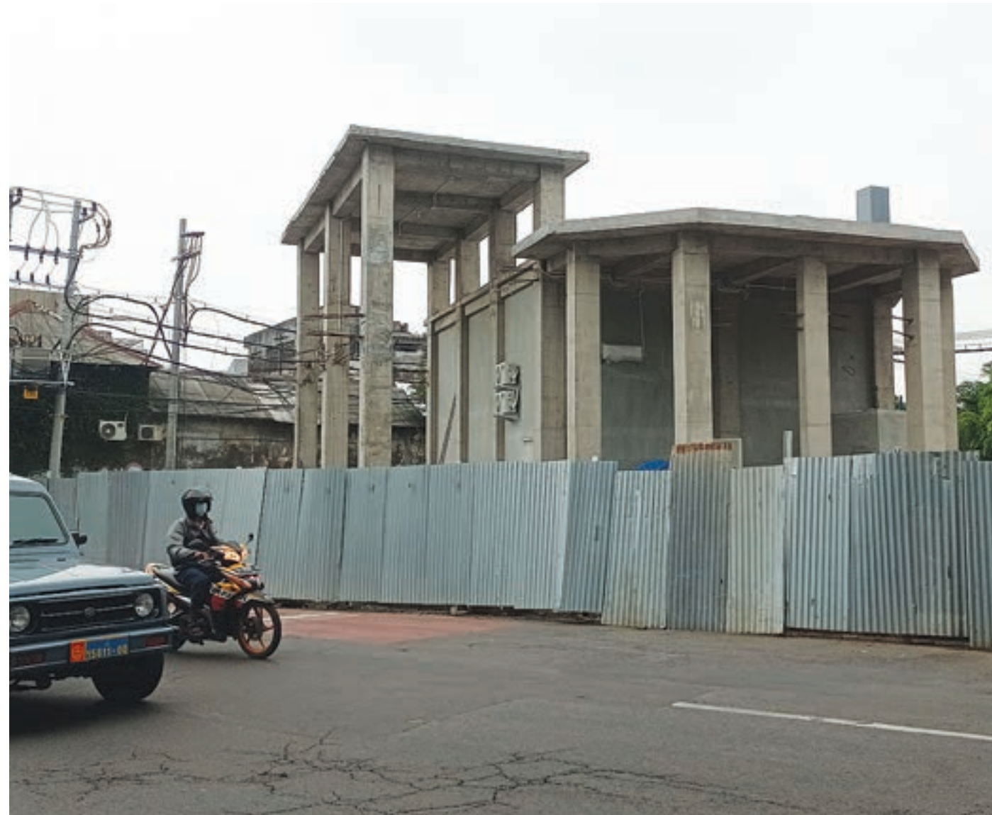
KERJA KERAS: Pembangunan rumah pompa terus dikebut karena menjadi salah satu strategi Kota Surabaya agar banjir tidak terjadi.
