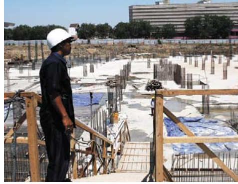
Pekerja AdhiKarya menyelesaikan basement Mall dan The Via & The Vue Apartment
