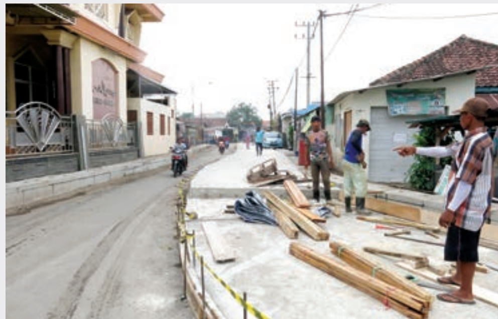
DIKEBUT: Pengecoran jalan di Desa Kemiri Sidoarjo. Tahun 2019 pengecor jalan memakai system baru yang lebih cepat agar tidak mengganggu aktifitas warga.
