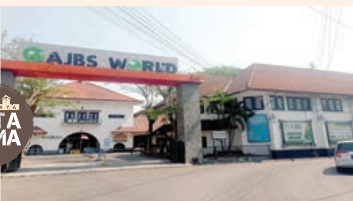
SURYANTORADAR SURABAYA BANYAK YANG DIUBAH: Bekas pabrik bir di Jalan Ratna ini masuk dalam bangunan cagar busaya tipe c.
