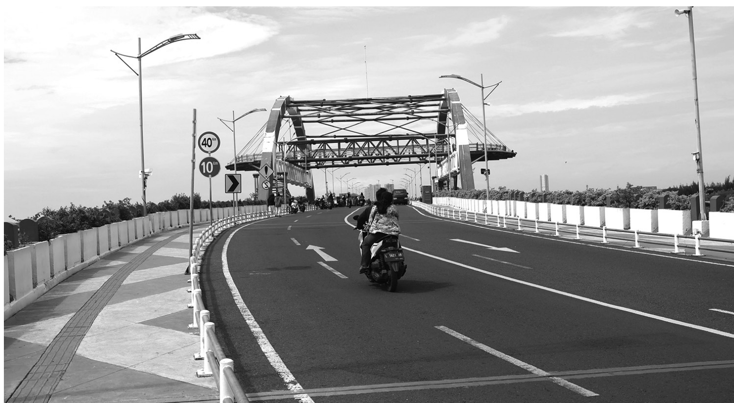
SERR: Jalan di kawasan Jembatan Suroboyo nantinya akan terkoneksi dengan Surabaya East Ring Road yang menghubungkan Bandara Juanda dan Pelabuhan Tanjung Perak.
