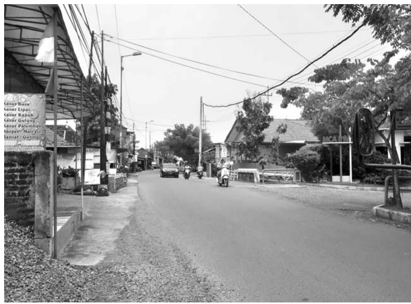
BIAR AMAN: Jalan Raya Sumorame Candi yang akan dipasang rambu lalu lintas baru. Total ada 28 rambu baru yang akan dipasang di empat lokasi yang berbeda.
